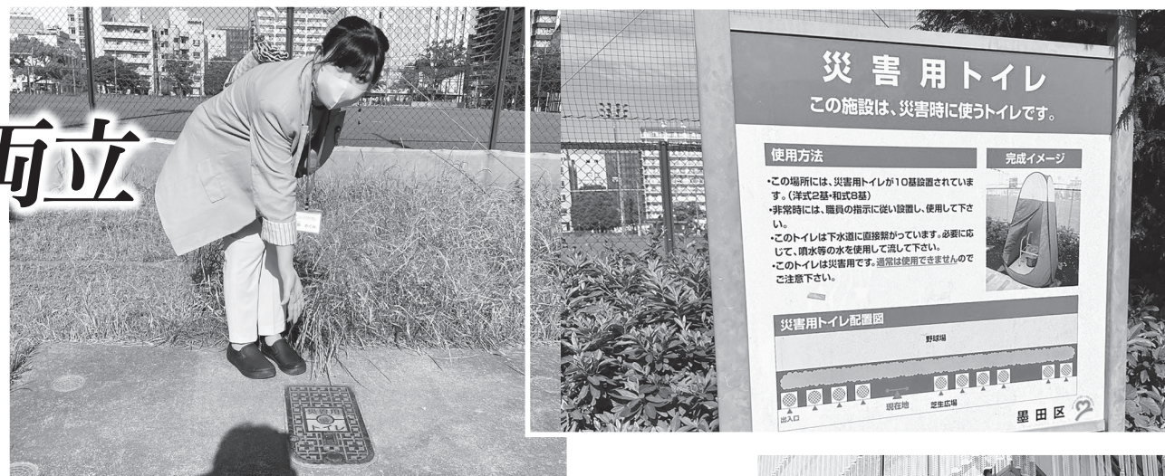
マンホールトイレを確認する池田市議(左)と使用方法を知らせる案内板(右)
